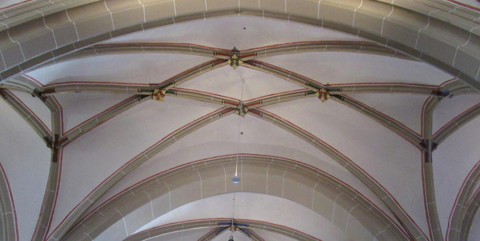
**Kreuzrippengewölbe.** Durch Ableitung des Gewichts auf die Pfeiler ermöglicht das gotische Kreuzrippengewölbe größere Höhen. In bewegter Linienführung überspannen Rippen die Kirche, so dass sich im Seitenschiff Netz-, im Mittelschiff Stern- und im Chor ein Kreuzgewölbe bilden. Gehalten wird es durch den Schlussstein am Kreuzungspunkt, der für Christus steht.
